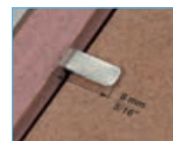
Construção de caixilhos
