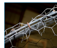
Costruzione gabbie Cage manufacture
