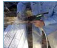
Estructuras metalicas Grades metálicas
