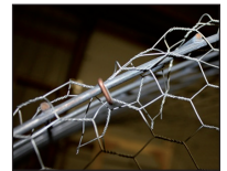
Costruzione gabbie Cage manufacture
